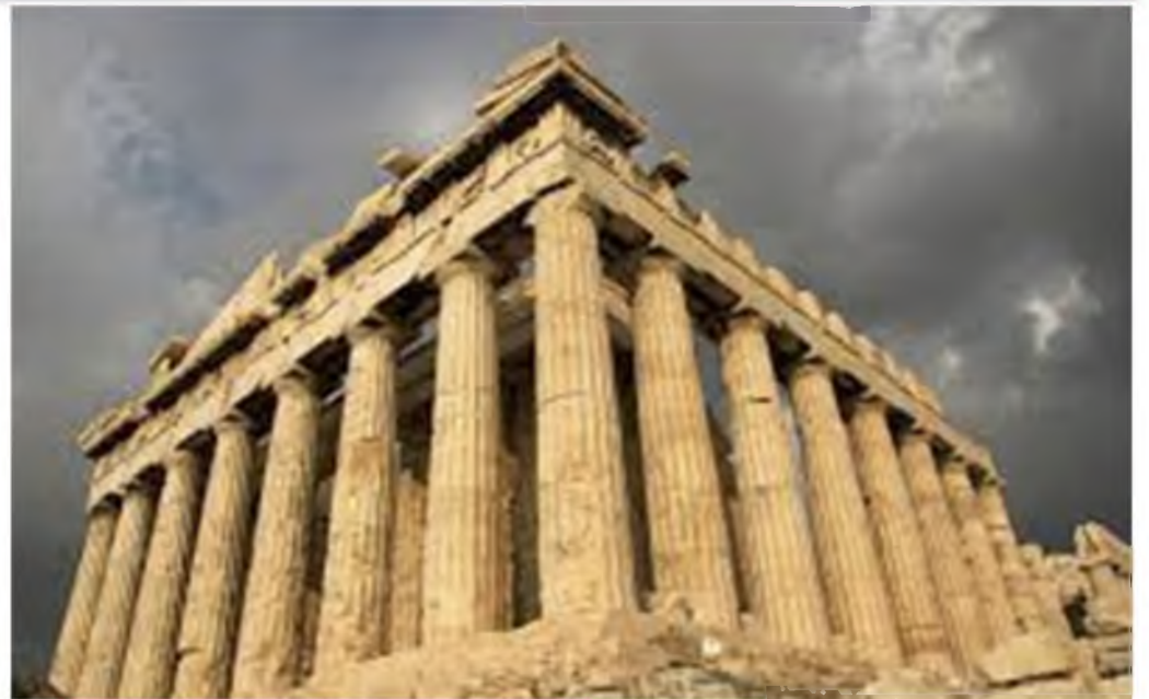
Deschideri în acoperișul unui templu
